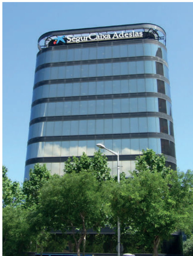
SegurCaixa Adeslas ha adquirit la propietat de la Torre Nord a Juan Gris, a Barcelona, després del procés de segregació amb VidaCaixa
